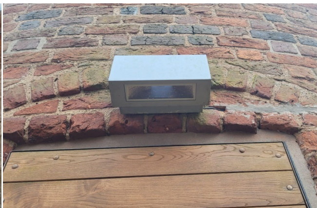
Uszkodzona oprawa oświetleniowa nad wejściem
