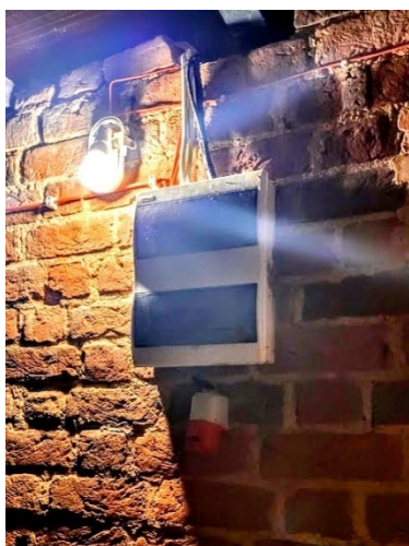
Tablica bezpiecznikowa, gniazdo 3x32A, 400V, uszkodzona oprawa
